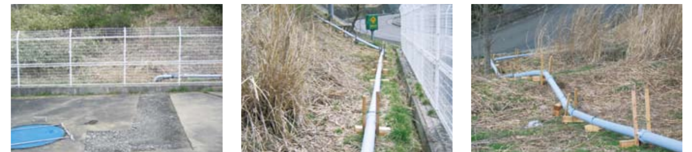
写真4. 圧送下水の露出仮設配管 (左:マンホールポンプからの取り出し、中央、右:配管状況)
